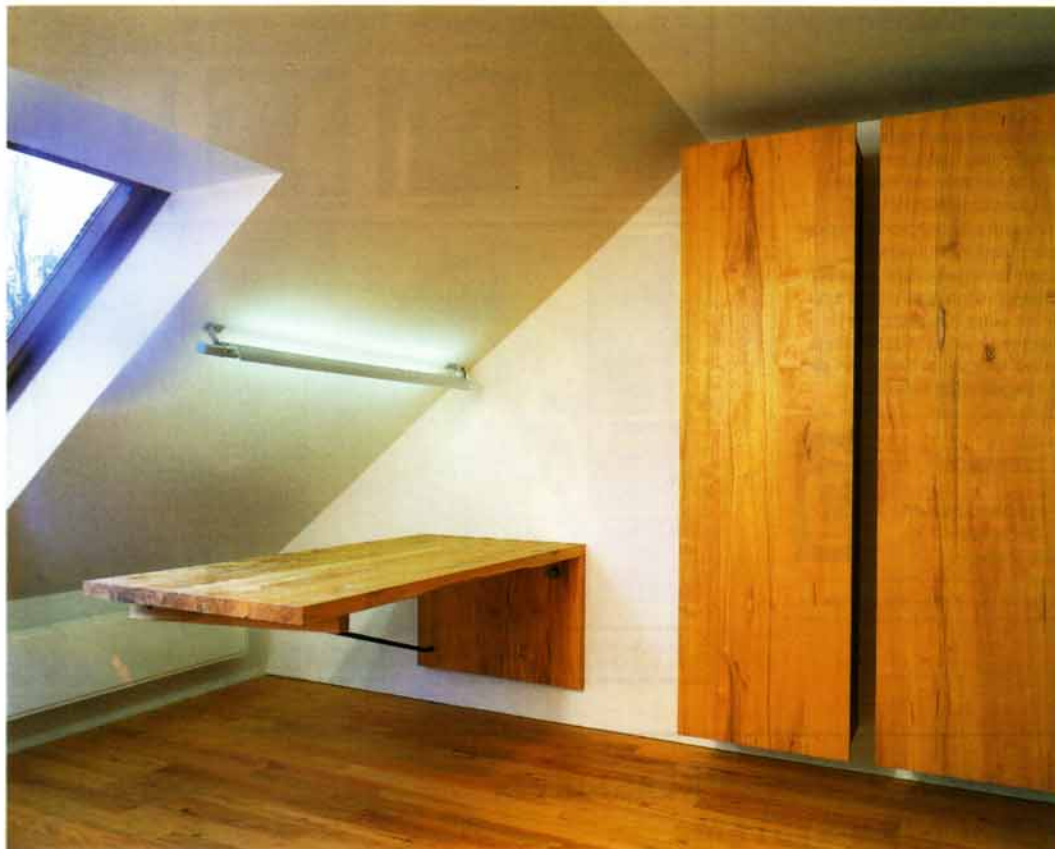
Blick auf einen der beiden Arbeitsplätze im Dachgeschoss, bestehend aus einer frei aufgehängten Platte in massiver Robinie sowie zwei Schrankkorpusen
