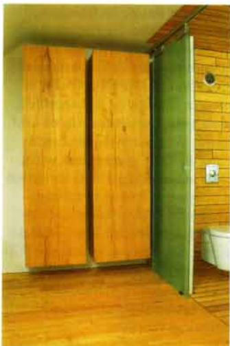
Die Schrankkorpusse in Robinie, furniert mit Brettüren, sind mittels Keilleisten auf Abstand zum Boden aufgehängt. Die Türen stehen mittig zwischen den Korpusen über und ergeben somit die Griffe
