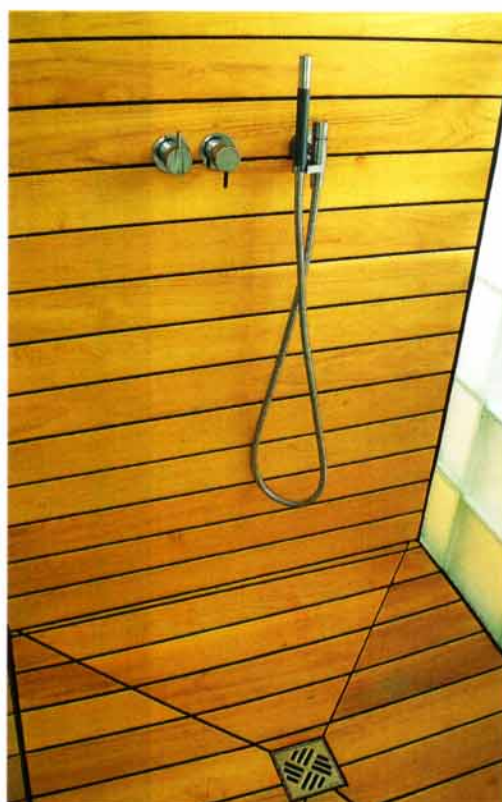
Blick in den Duschbereich mit konisch auf den Abfluss zulaufender Bodenausbildung. Deutlich zu erkennen die im Bootsbau üblichen Neoprenfugen zwischen den Bodenbrettern. Die Auswahl einer schlichten Armatur rundet auch das Bild ab
