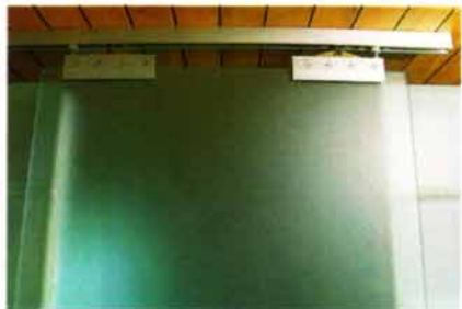
Sichtbare Konstruktions- und Beschlagdetails, wie hier im Falle der Schiebetüraufhängungen, sind ein Erkennungsmerkmal in Thomas Gröggers Entwürfen
