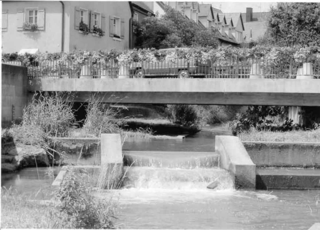
Wehr bei der Sägbrücke, Station 21
